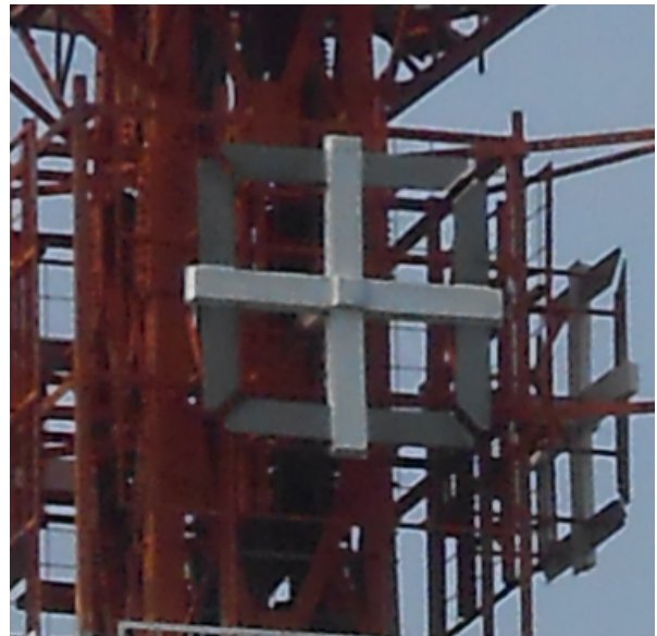
그림 1. CP-dipole 안테나 Fig. 1. CP-dipole antenna
